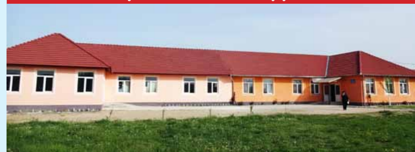
Het linker gedeelte van de basisschool moet van binnen nog afgewerkt worden
