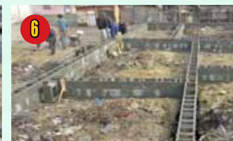
Rij stenen opgemetseld op de fundering
