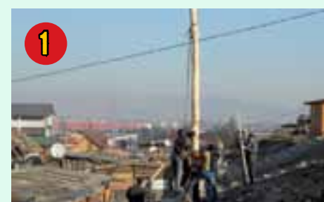
Plaatsen van een nieuwe paal voor de elektriciteitskabels
